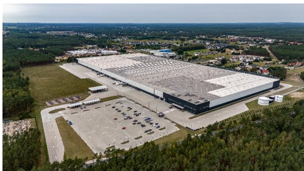
LPP Distribution Center, Bydhošť, Polsko
