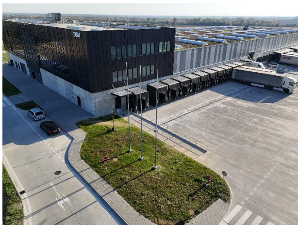
Logistické centrum DSV, Senec, SR
