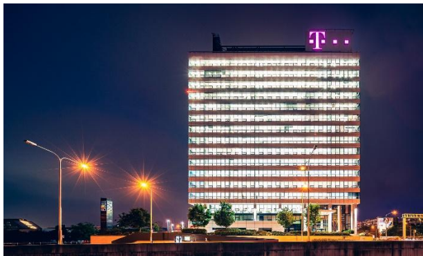
Administrativní budova Forum BC I, Bratislava, SR
